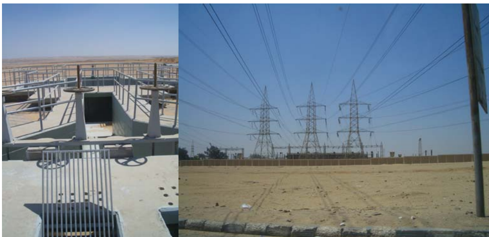
vorhandene klärteichanlage (l), hochspannungsüberlandleitungen(r)
